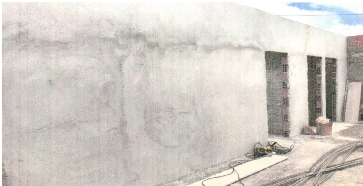
FOTO 05 – MASSA ÚNICA, PARA RECEBIMENTO DE PINTURA OU CERÂMICA, ARGAMASSA INDUSTRIALIZADA, PREPARO MECÂNICO, APLICADO COM EQUIPAMENTO DE MISTURA E PROJEÇÃO DE 1,5 M 3 /H EM FACES INTERNAS DE PAREDES, ESPESSURA DE 5MM, SEM EXECUÇÃO DE TALISCAS. AF_06/2014
