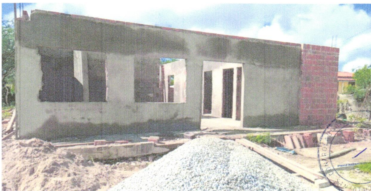
FOTO 06 – ALVENARIA DE VEDAÇÃO DE BLOCOS CERÂMICOS FURADOS NA HORIZONTAL DE 9X19X29 CM (ESPESSURA 9 CM) E ARGAMASSA DE ASSENTAMENTO COM PREPARO EM BETONEIRA. AF_12/2021
