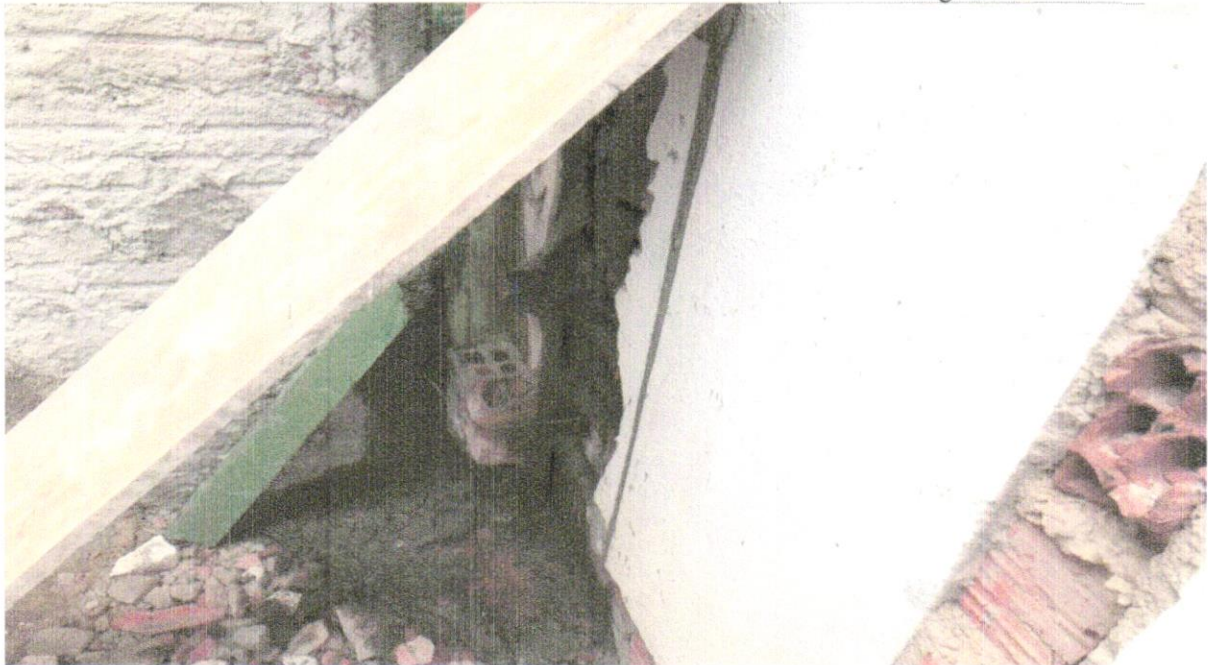
FOTO 03 - CONCRETO FCK = 20MPA, TRAÇO 1:2,7:3 (EM MASSA SECA DE CIMENTO/ AREIA MÉDIA/ BRITA 1) - PREPARO MECÂNICO COM BETONEIRA 400 L. AF_05/2021
